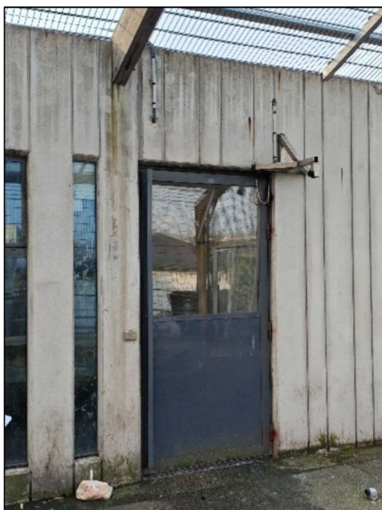
Implantation organe de verrouillage porte toilette
